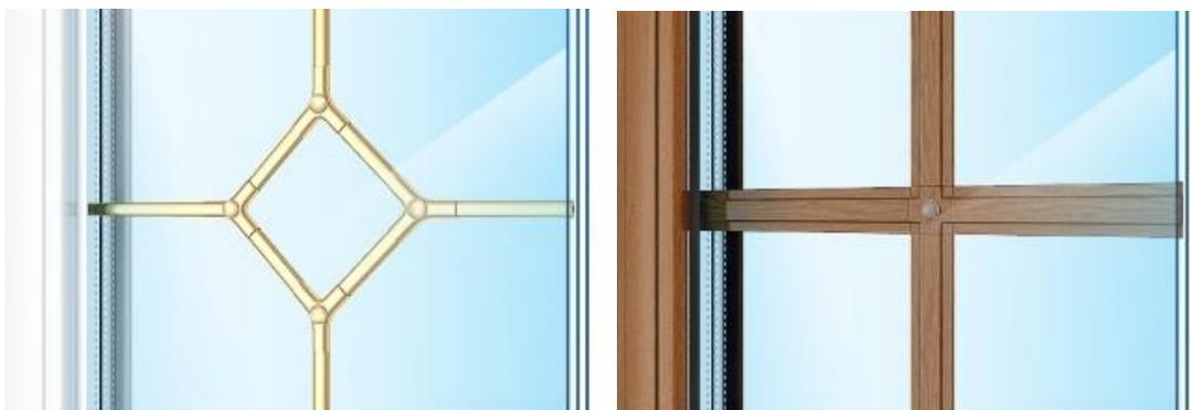
Помимо эстетической функции, внутренняя декоративная раскладка является технически необходимой для больших стеклопакетов, особенно – в условиях низких температур. Здесь она позволяет дополнительно защитить окно от внешних воздействий, которые могут привести к деформации стеклопакета.
